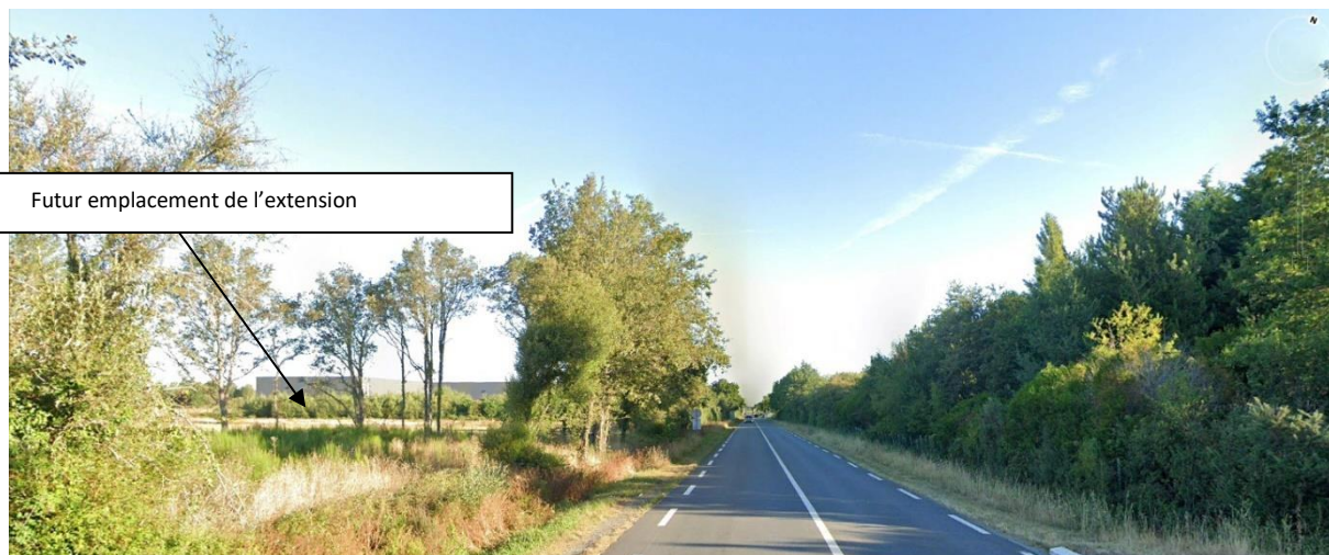
Vue n°7 : Vue lointaine de la partie sud de l'actuel terrain à réaménager (depuis le croisement RD957 / VC n°8 La Couilladais)
